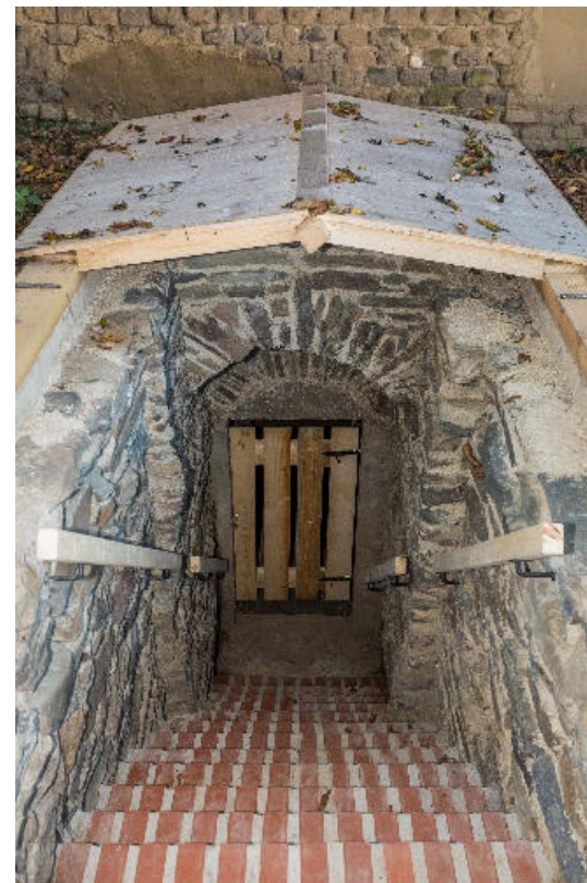
■ Vstup do sklepa po opravě
