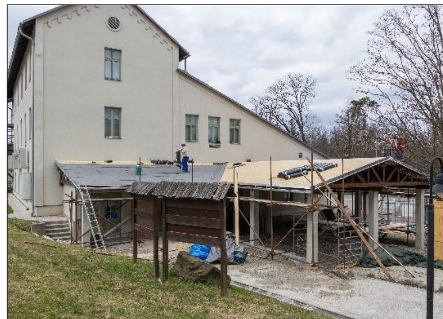
■ Budování nového přístřešku u Sušáku
