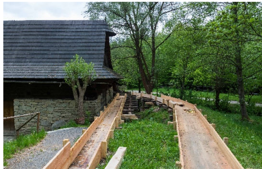
■ Oprava lamfeštů v Mlýnské dolině
