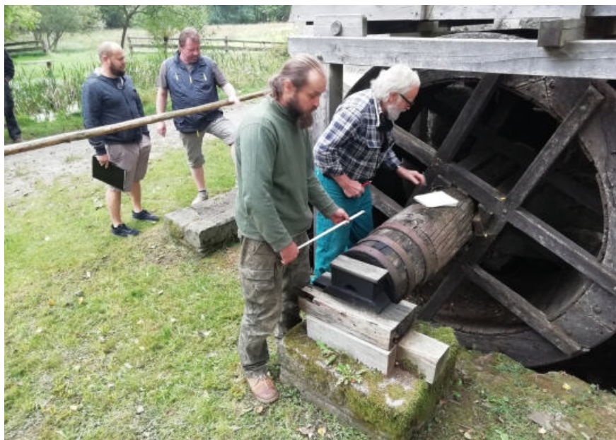
■ Oprava vodních kol
