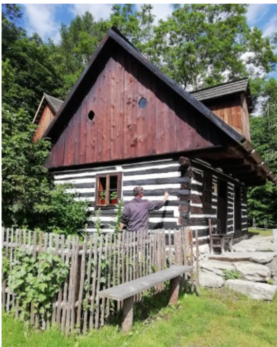
Konzervace roubení expozičního objektu
